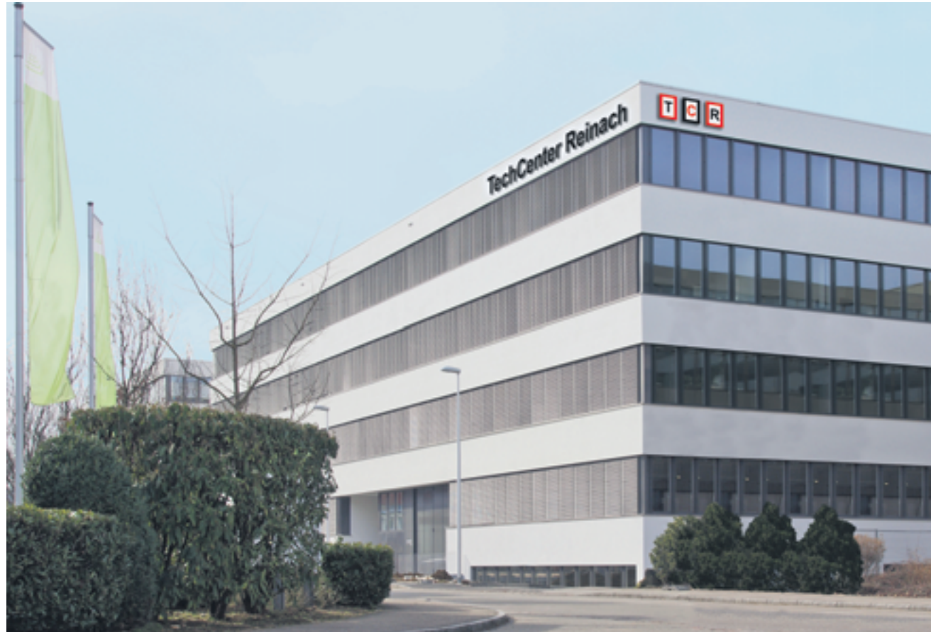
Das TechCenter Reinach bietet effiziente Infrastrukturen und eine flexible Flächennutzung, www.techcenter-reinach.ch Fotos: zVg
