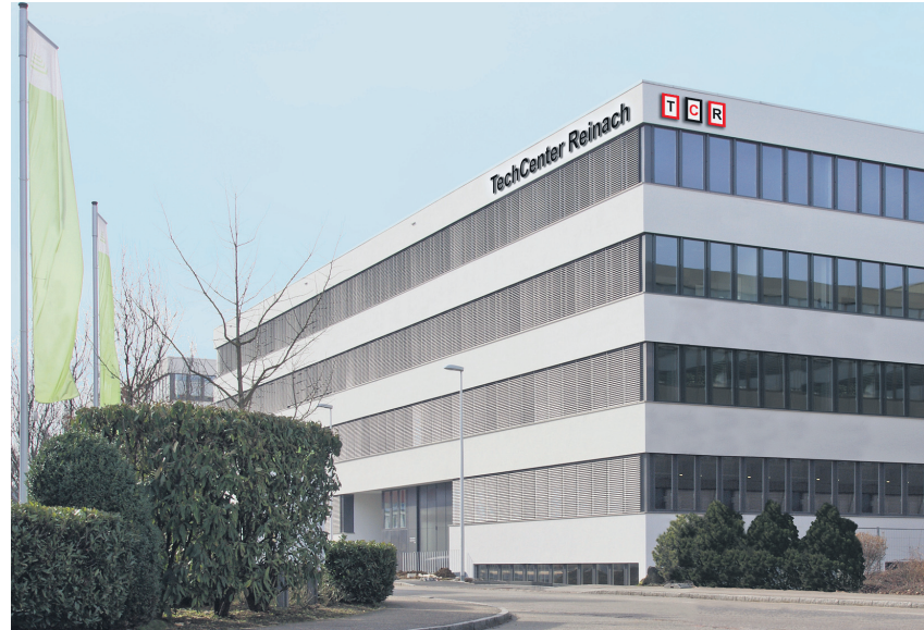
Das TechCenter Reinach bietet effiziente Infrastrukturen und eine flexible Flächennutzung, www.techcenter-reinach.ch
